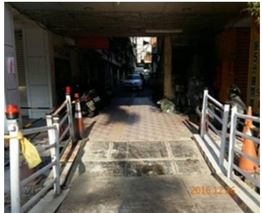
改善後:立即以護欄區隔工區與人行動線
