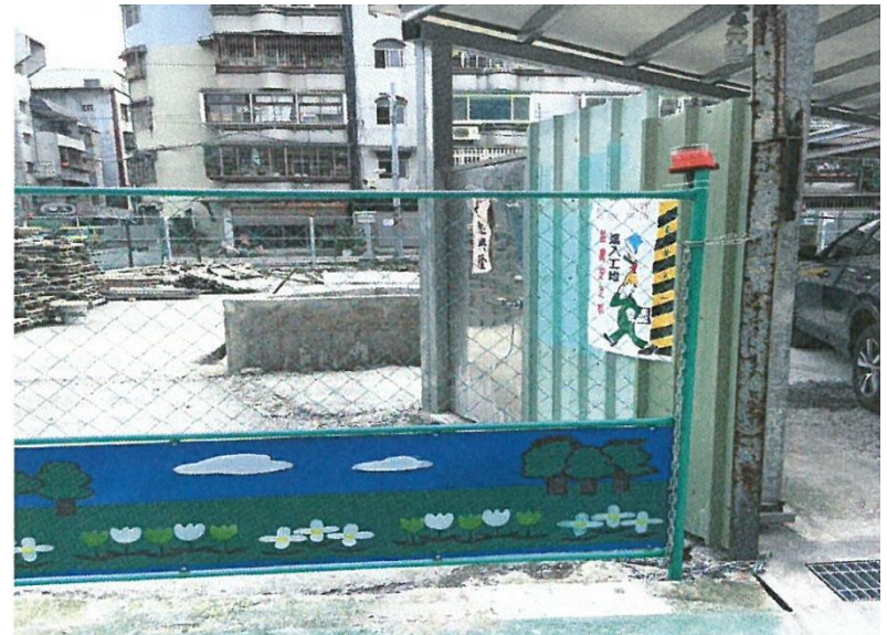
改善後，封閉圍籬缺口
