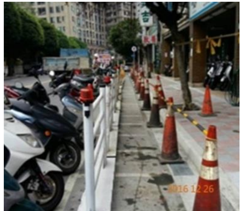
改善後：臨道路側使用護欄，人車分離
