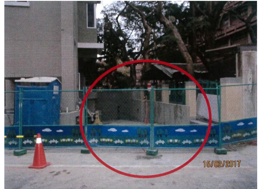
改善後，封閉圍籬缺口
