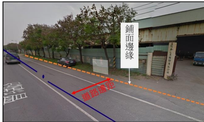
圖十一、無邊溝，道路邊界不易確定，以「鋪面邊緣線」為基準。
