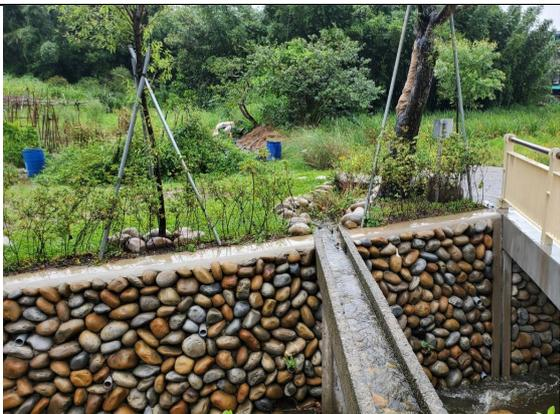
圖號19 渡槽回復功能兼串聯左右岸生物通道
