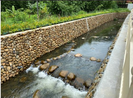
圖號15 砌石梁穩固渠底回填石，維持生態基流量，增加曝氣
