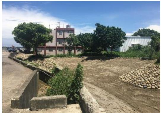
溝渠採用砌石施作，空曠處作為生態池使用，其裸露地後續進行植生工程，形成草溝補償原生物棲地，部分樹木保留，若影響渠道之樹木將進行遷移。
