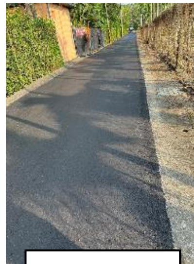
潮州鎮鋪面工程
