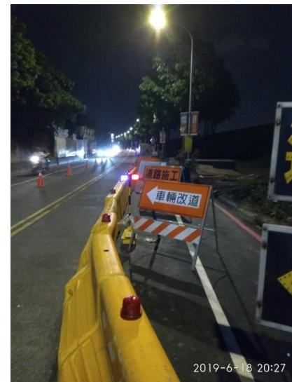
職安夜間查核 (交維設施)
