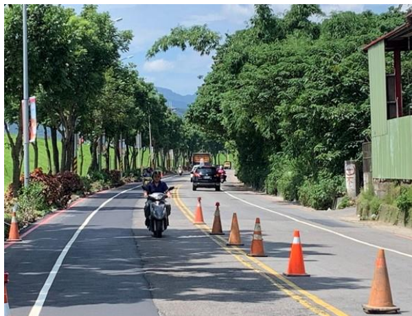
職安日間查核 (交維設施)
