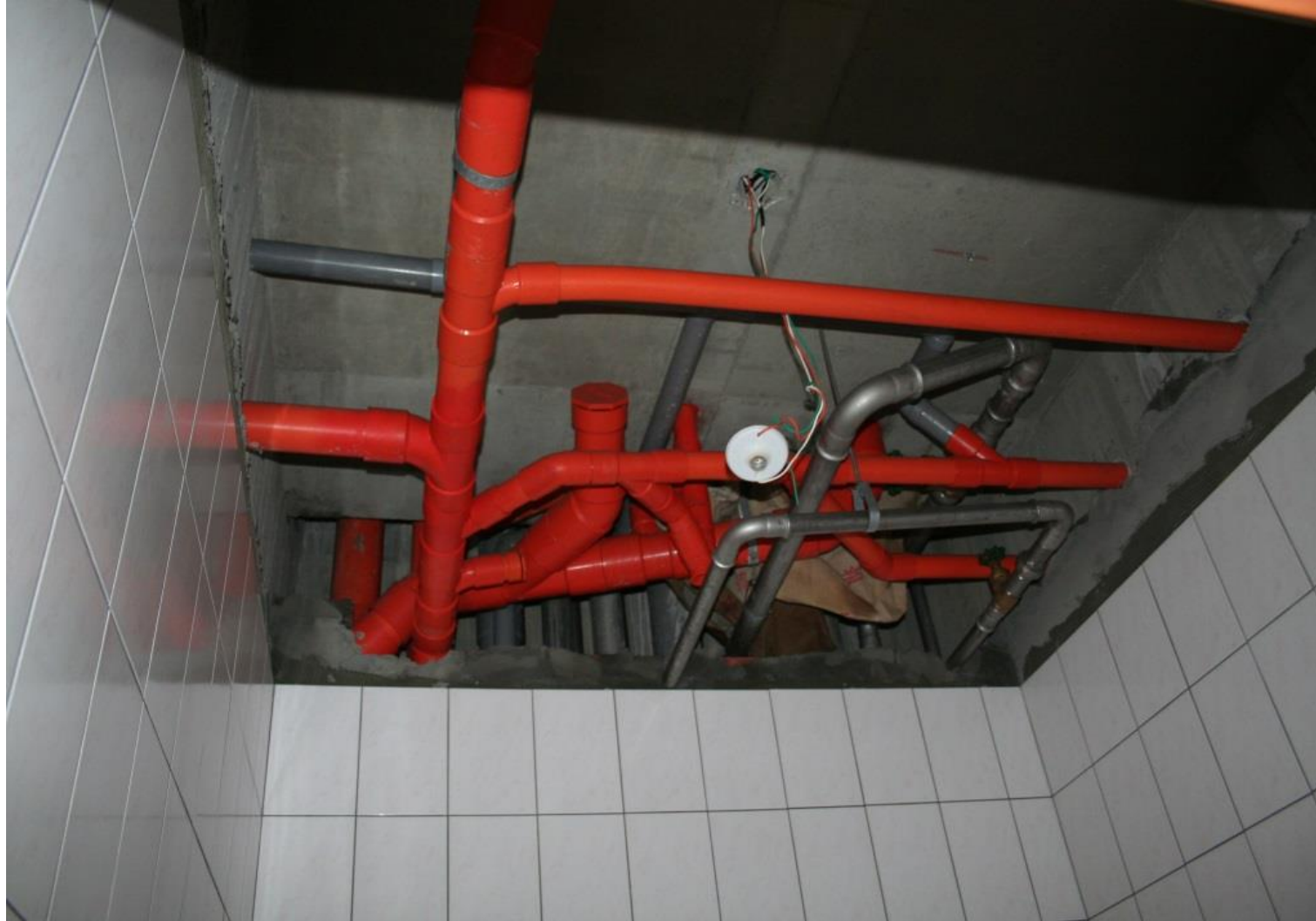
圖94工程會扣點編號5070412 說明：出線口與燈具連接未使用軟管
