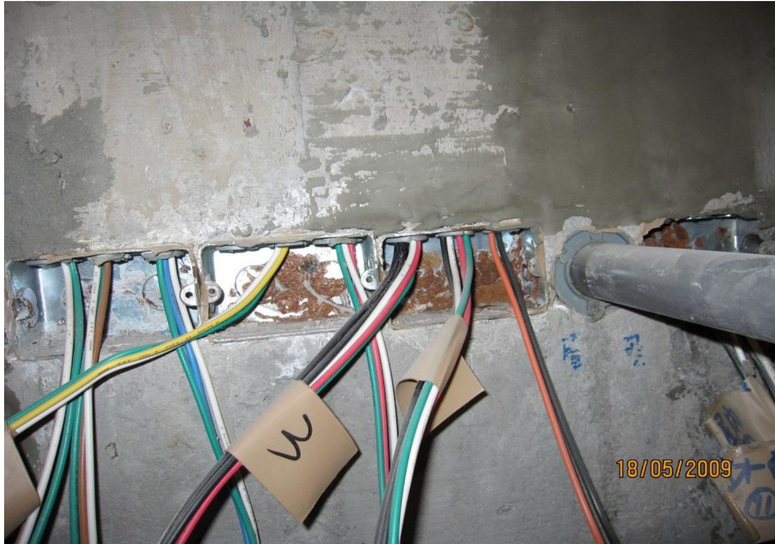
圖63工程會扣點編號5070407 說明：出線盒生銹不潔，降低材料品質。
