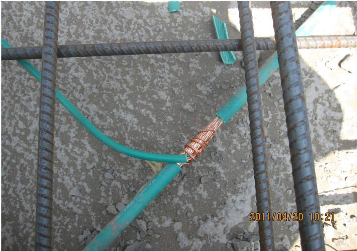
圖128工程會扣點編號5070699 說明：接地導線連接法不當，不符法規規定
