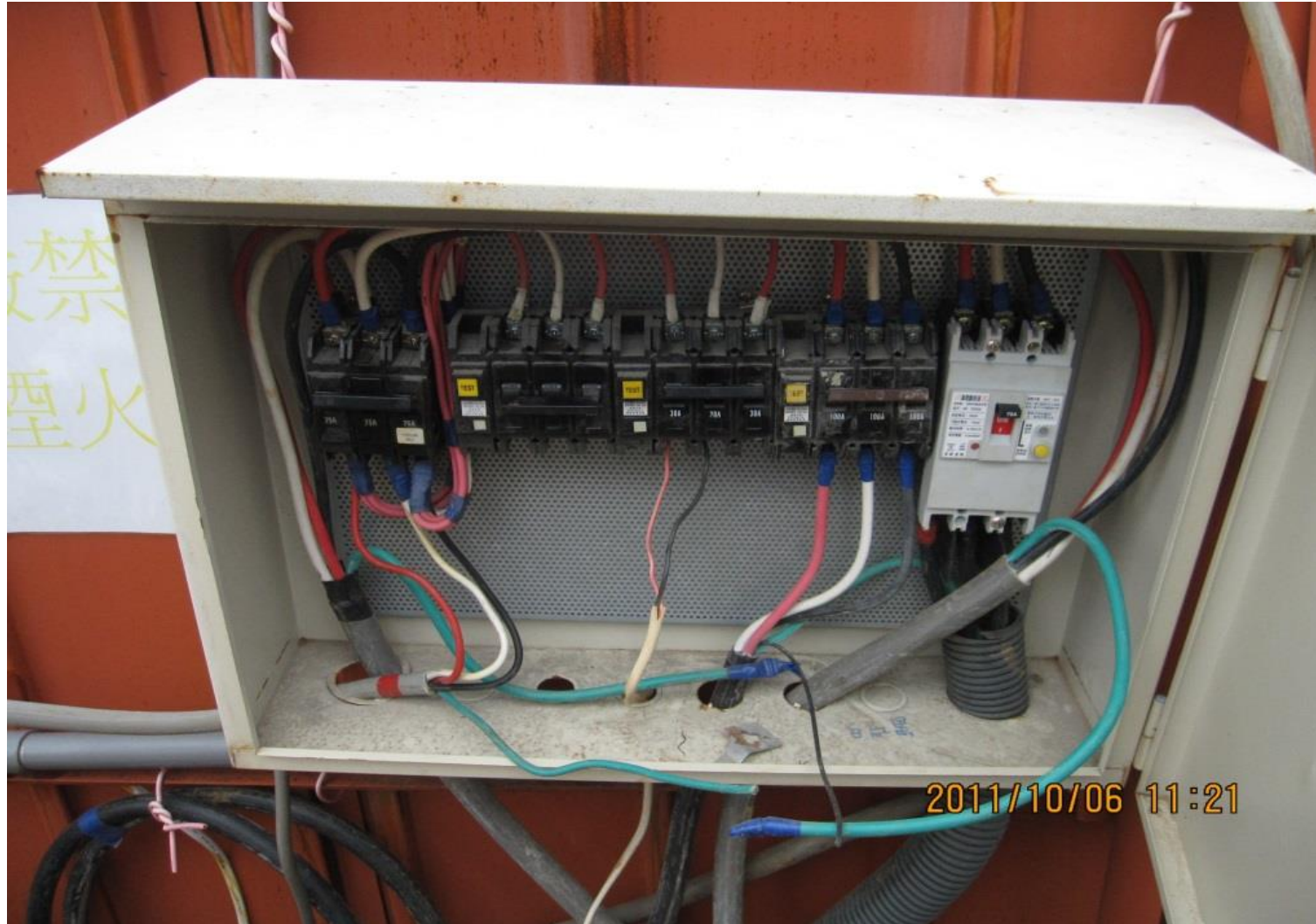
圖125工程會扣點編號5070606 說明：臨時電未接地
