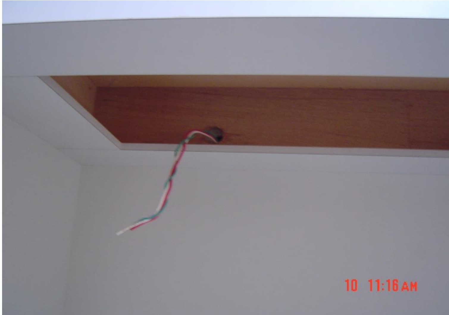
圖95工程會扣點編號5070412 說明：出線口與燈具連接未使用軟管
