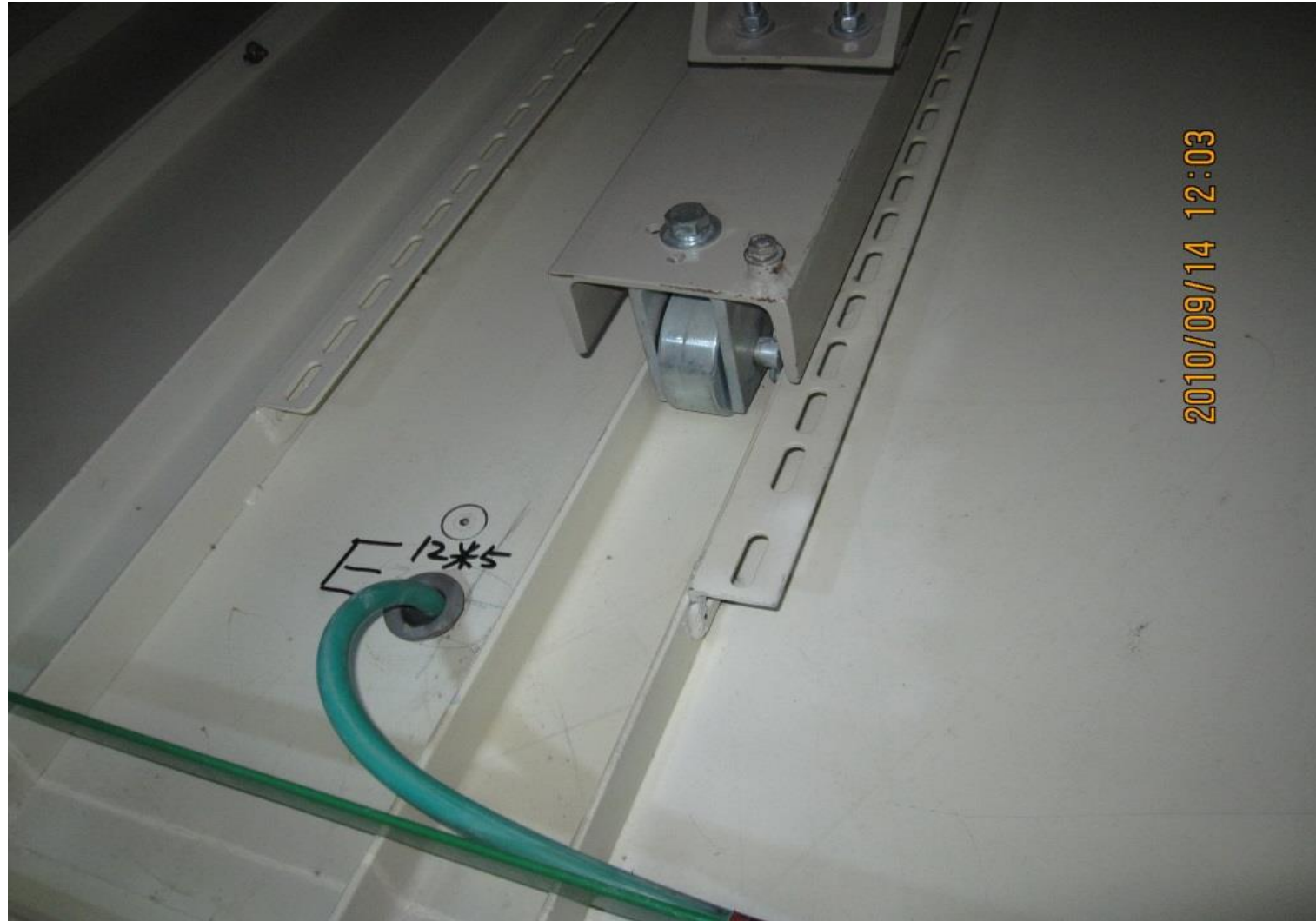
圖106工程會扣點編號5070427 說明：模鑄式變壓器輪子固定不當
