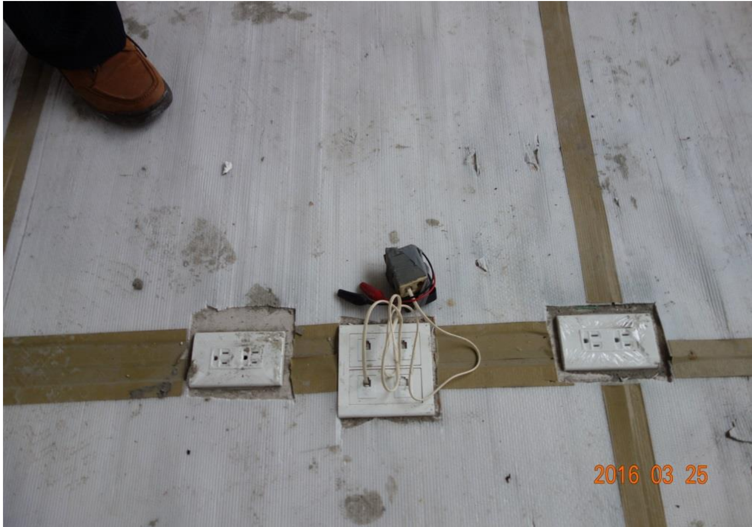
圖100工程會扣點編號5070416 說明：地板插座規格選用不當
