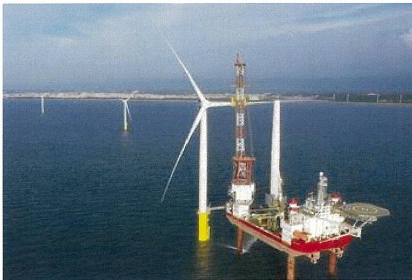
圖 4-9 離岸風機工作船作業狀況
