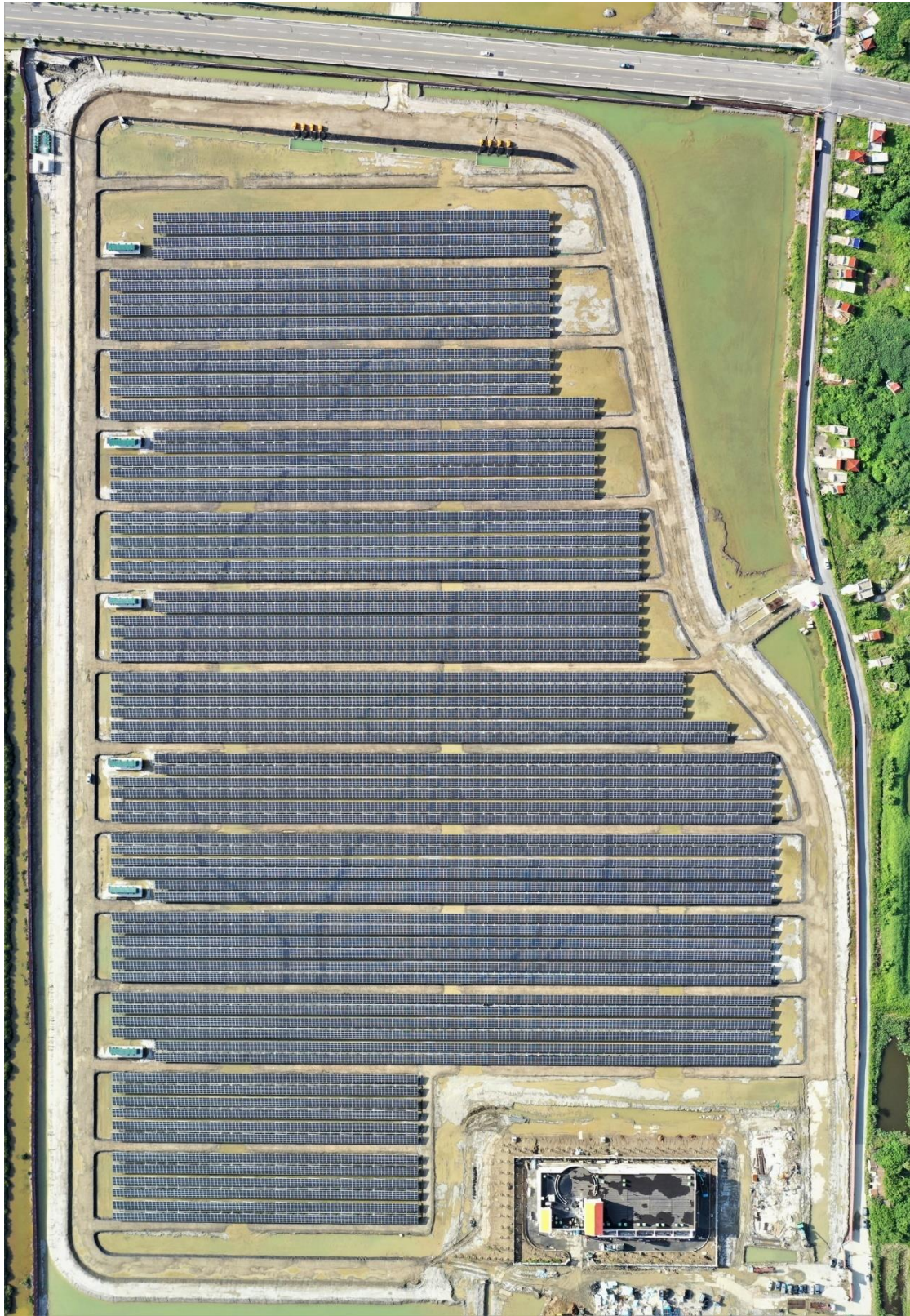
圖 7 台南鹽田光電站空照圖
