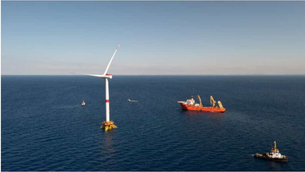
圖 1-2 法國 PROVENCE GRAND 浮台拖航與安裝工作船隊組成
