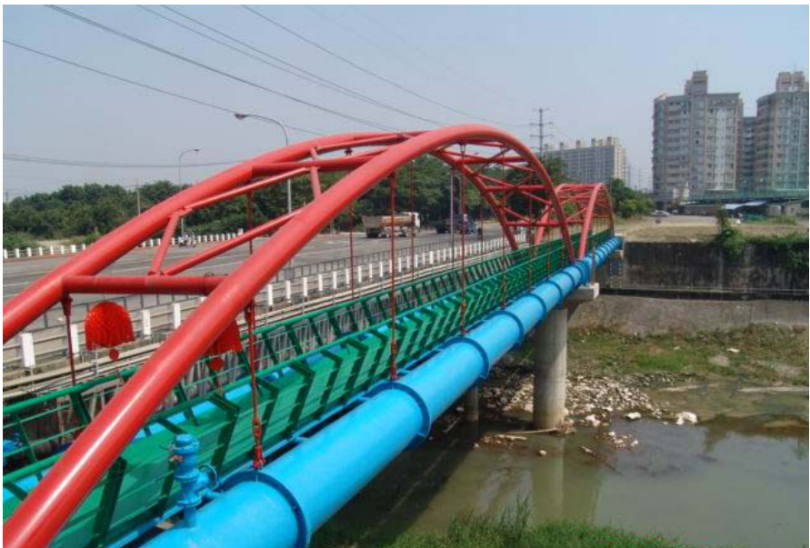
■ 高雄楠梓左營地區供水改善工程完工通水
