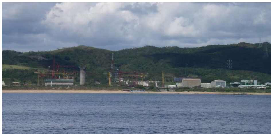
■ 台電公司核四廠工地海上遠眺
