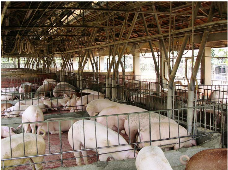
■ 台糖肉豬舍自動餵料設備
