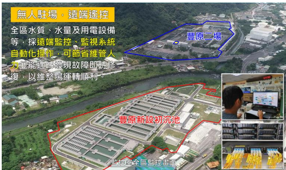
■ 台水公司--豐原前處理機電整備工程榮獲行政院工程會金質獎
