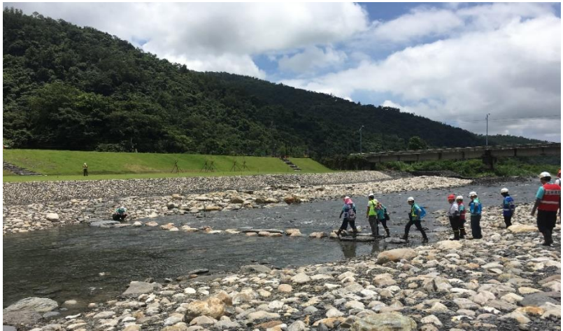
■ 經濟部水利署第一河川局「大礁溪橋上游段河川環境改善工程」
