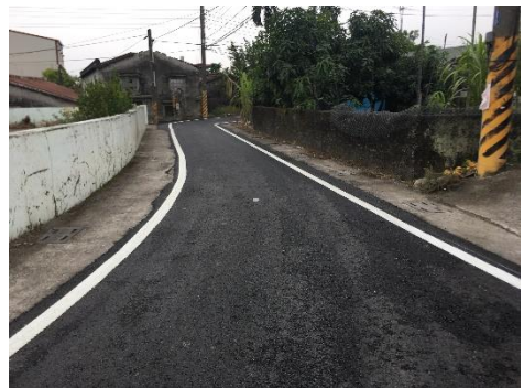
■台水公司--桃園－新竹備援管線工程
