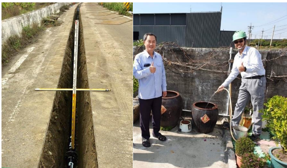
■ 台水公司--延管工程施工作業(左)，完工後民眾啟用自來水(右)
