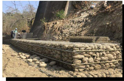
圖10 箱型石籠工法
