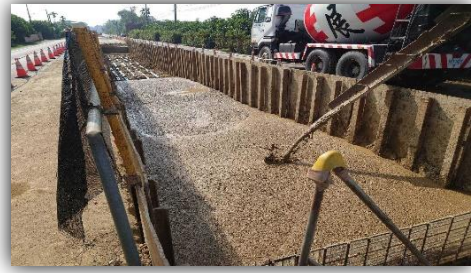
圖4預拌土壤材料（RMSM）回 填施工
