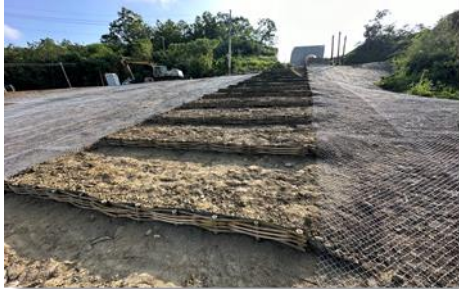
圖8-1 打樁編柵工法1
