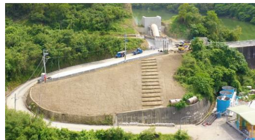
圖8-2 打樁編柵工法2
