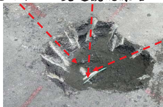
電力管 交通號誌線路
