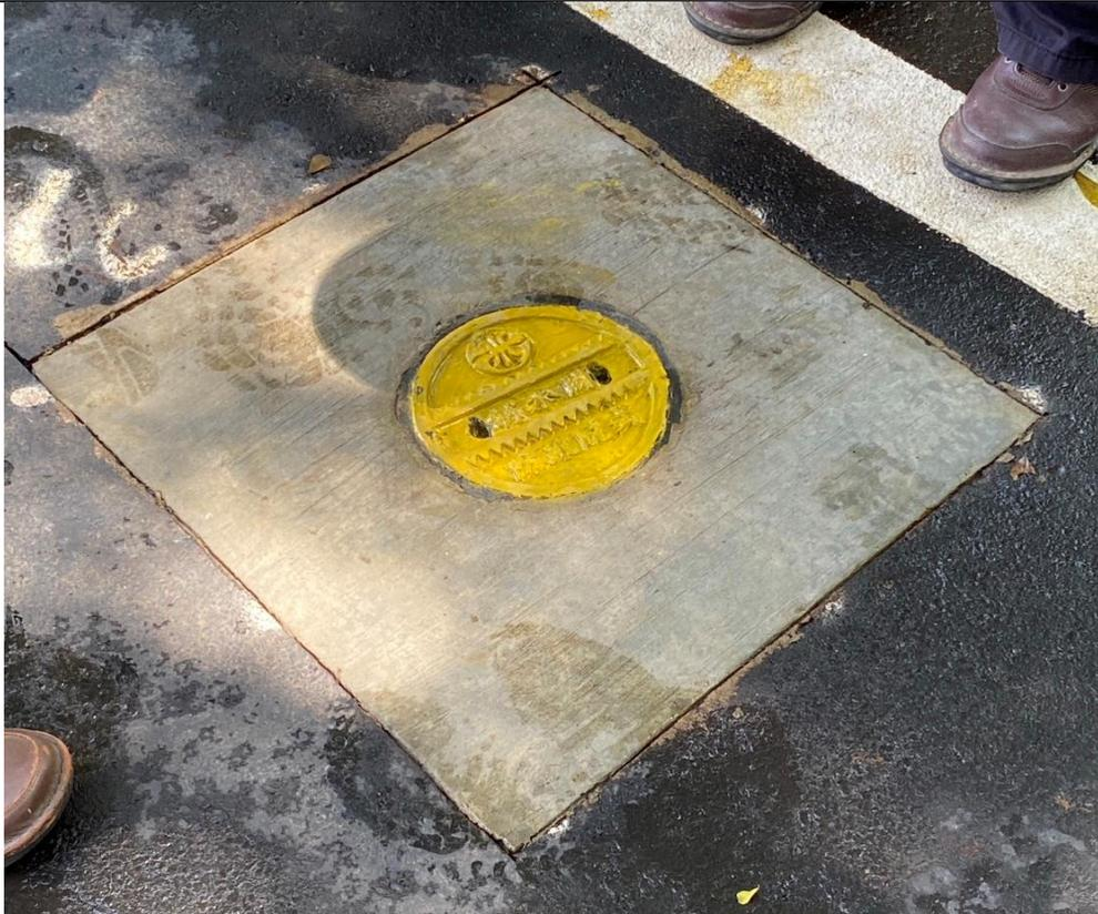
說明 | 制水閘盒固定座與瀝青混凝土之介面，有部分孔隙未補實情形。
