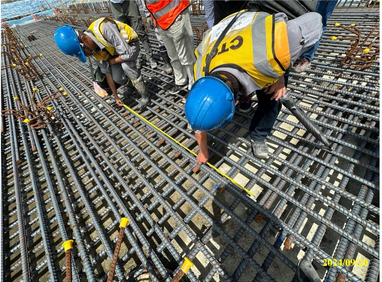
說明 電氣室工程處部分鋼筋墊塊間距不符規定。
