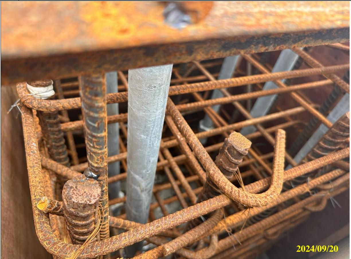
說明 管架工程、電氣室基樁樁頂部分鋼筋施工鋼筋表面銹蝕嚴重。
