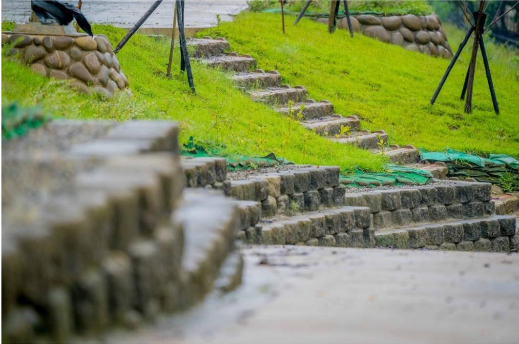
(圖一)既有護坡磚、高壓磚再利用
