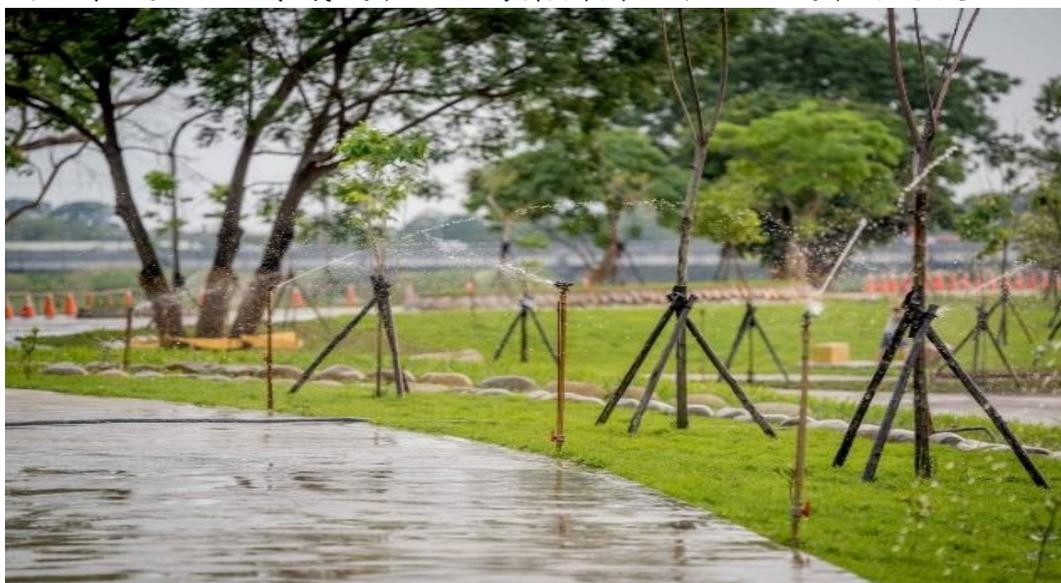
(圖八) 工程初期以水車定期灑水，土方培厚至設計高程後佈設澆灌系統，定期灑水抑制揚塵，可減少水車運行耗能。
