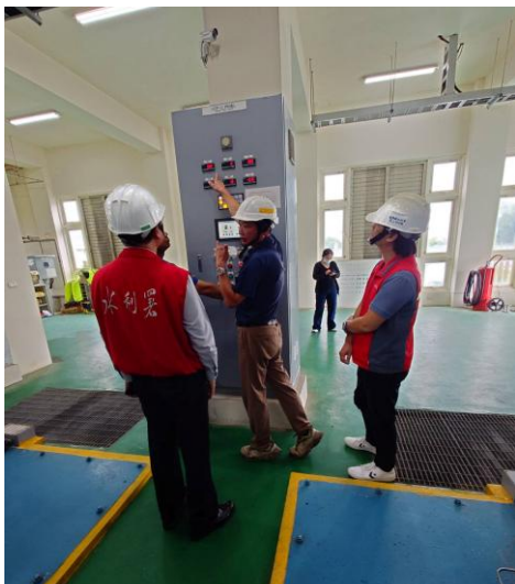
新竹南寮抽水站
