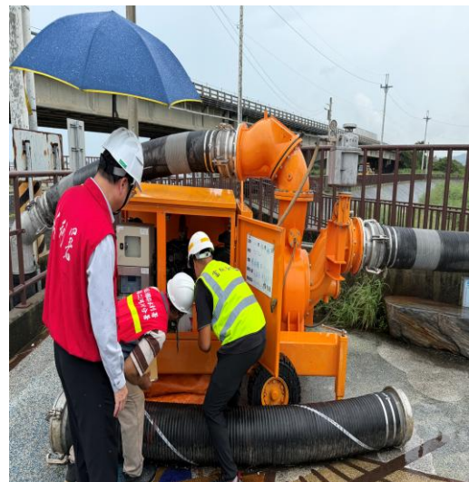
新竹舊港島抽水機
