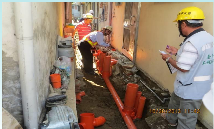
102.10.30查核鹽埕D污水分區分支管網及用戶接管工程第三標
