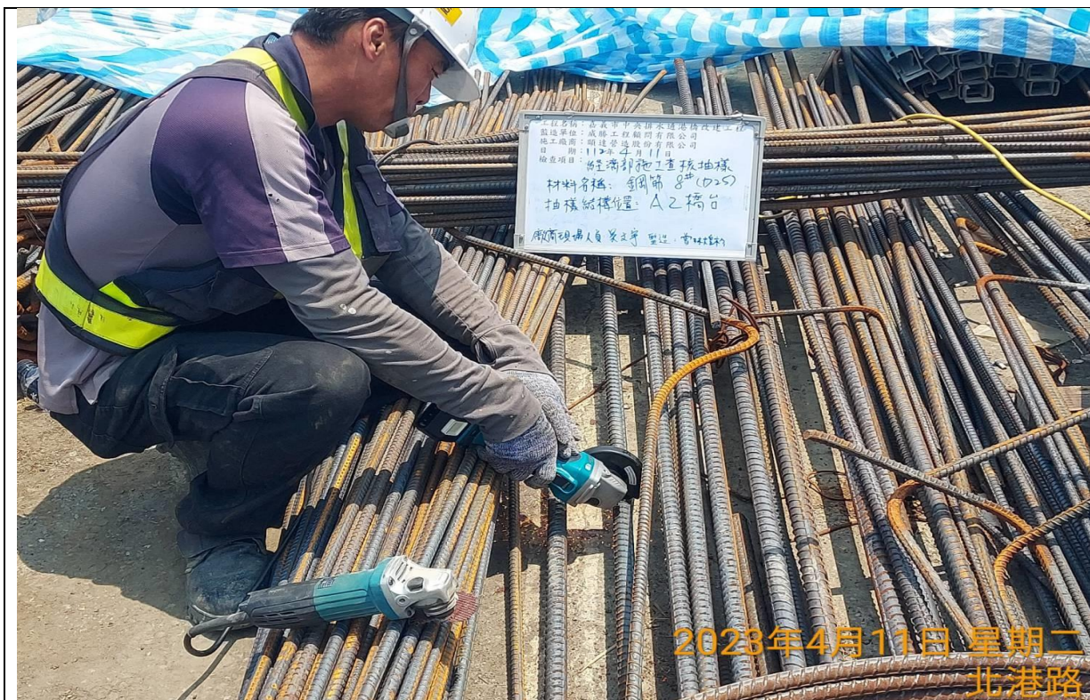
說明 | 查核當日現場鋼筋取樣試體。
