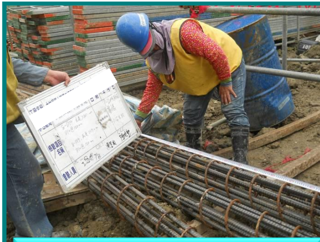
樁頭鋼筋籠檢查
