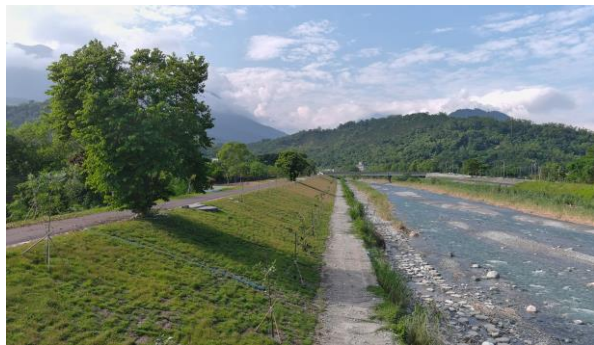
圖五、緩坡設計，打通橫向動物通道。
