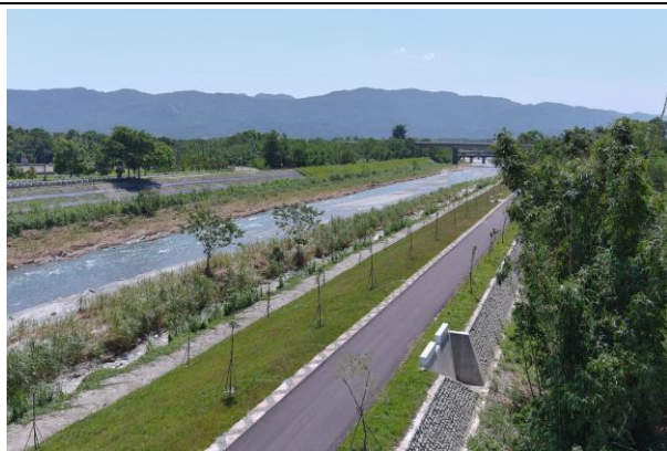
圖二、後坡設置生態廊道。
