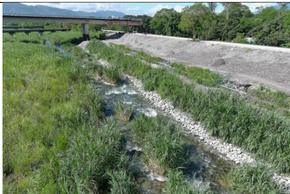
圖十、第四層箱籠拆除後，做為河道拋石材料來源。
