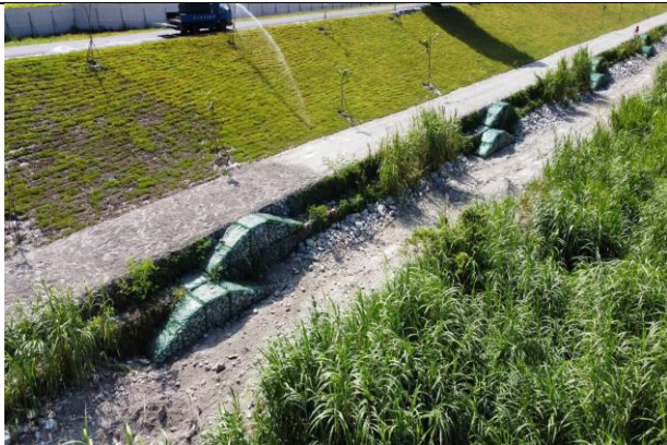
圖一、前坡設置特製箱籠。
