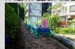
已設圍籬，阻絕人員靠近，並加設警語「非工作人員請勿進入」，以達安全維護。 審查通過 基隆市政府工務處
