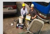
附件六-1假日監工人員皆依規定到場查驗 審查通過 基隆市政府工務處
