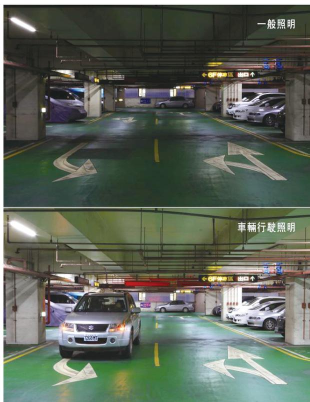
LED路燈與停車場智慧照明管理系統，全面掌握內、外部環境的變化，當車輛行駛於車道時，自動感測、判讀，立即將原車道一般照明（上圖），提高至安全行車採光亮度（下圖）。
