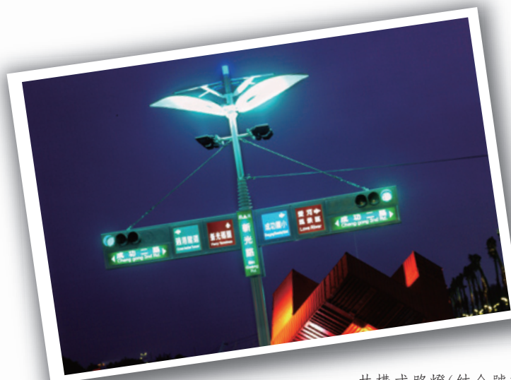
—— 共構式路燈(結合號誌、照明、標誌於一體)
